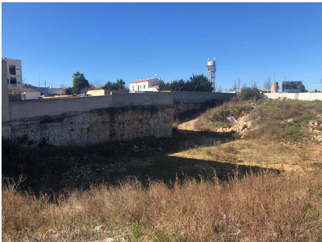
Estado actual de la parcela. Obsérvese el tajo que denota las actividades de excavación que ya se han desarrollado tiempo atrás.
