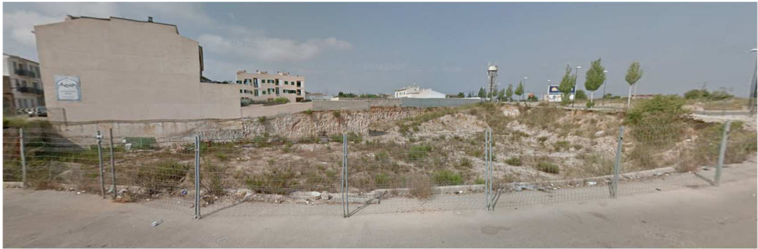
Figura 4. Visual de la zona de intervención urbanística desde el vial que conecta la Ma-19 con la Calle Consolació.
